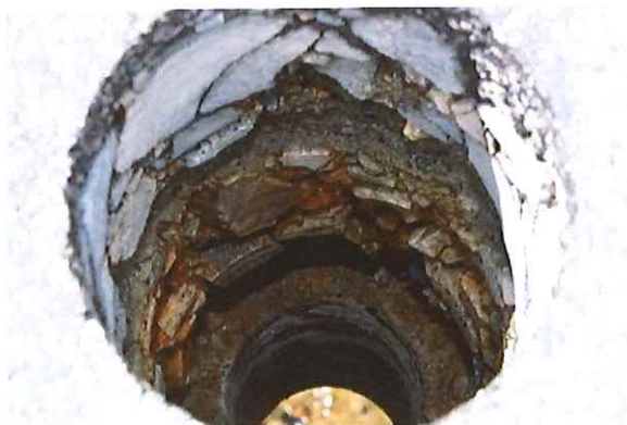
Foto 4.2.3 Detail jednotlivých vrstev viditelných na ostění po vyjmutí fragmentů jádrového vrtu
