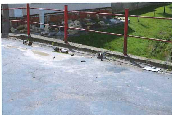
Foto 4.2.1 Pohled na provedené místo sondy do skladby vozovky a vrstev nad nosnou konstrukcí
