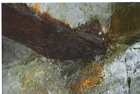
Foto 6.3 Detail uložení vnitřního I nosníku na podpoře před odstraněním povrchových zkorodovaných vrstev
