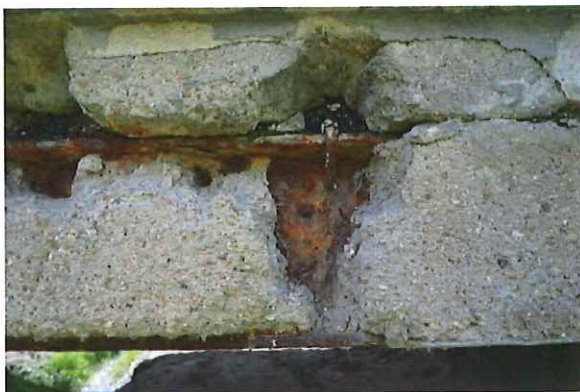
Foto 6.1 Pohled na boční líc nosné konstrukce s odhaleným krajním I profilem s výraznou povrchovou korozí a odpadenými vrstvami betonu tvořící obetonování nosníku
