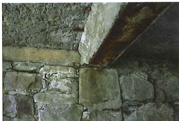
Foto 6.2 Detail uložení ocelového vnitřního I nosníku na kvádr větších rozměrů s viditelným obetonováním prvku vyjma spodního líce
