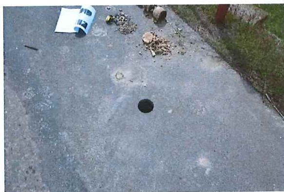
Foto 4.3.1 Pohled na provedené místo sondy do skladby mostního svršku v předpolí za nosnou konstrukcí mostu ve směru staničení
