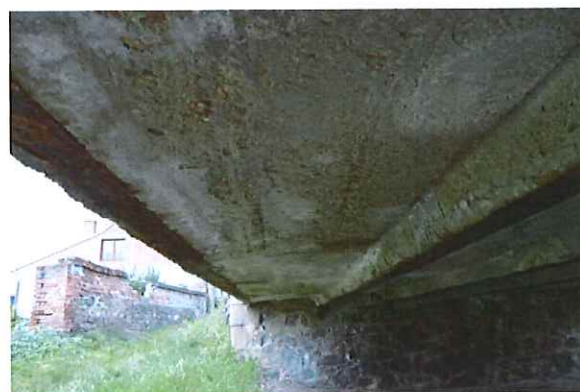
Foto 6.5 Pohled na spodní líc nosné konstrukce mostu s viditelným krajním a prvním vnitřním obetonováním
