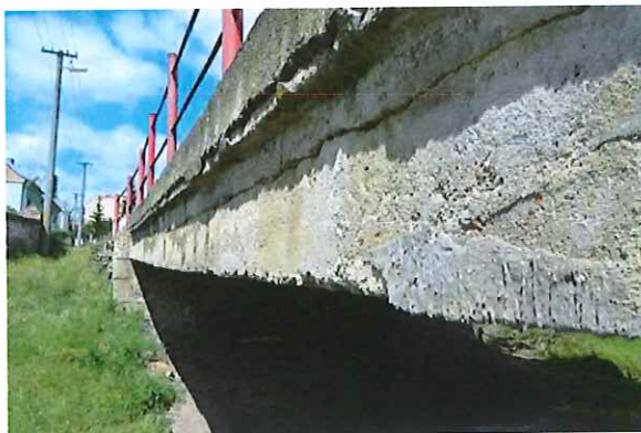
Foto 7.7 Detailní pohled spáru mezi nosnosu konstrukcí a betonovou římsou mostu
