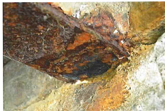
Foto 6.4 Detail uložení vnitřního I nosníku na podpoře po odstranění povrchových zkorodovaných vrstev
